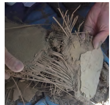
荒壁土の中に藁を伏せている様子
